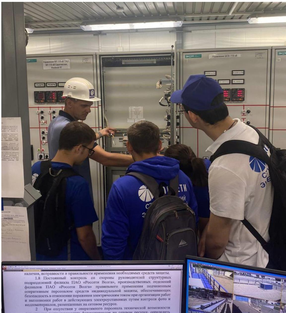
Рис. 4. Отряд «Импульс». Проверка блокировок вводно-распределительного устройства
